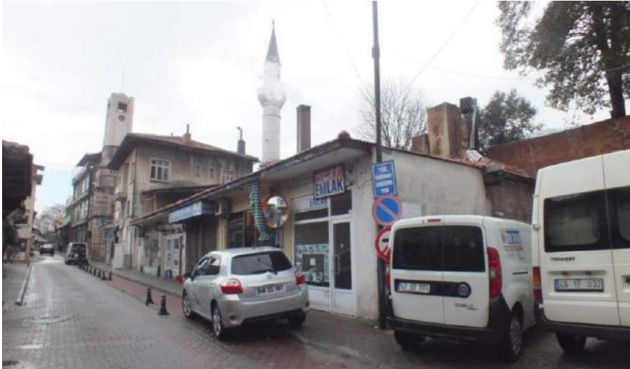
Fotoğraf 2- Muğla Şeyh Külliyesi, güneydoğudan genel görünümü.
