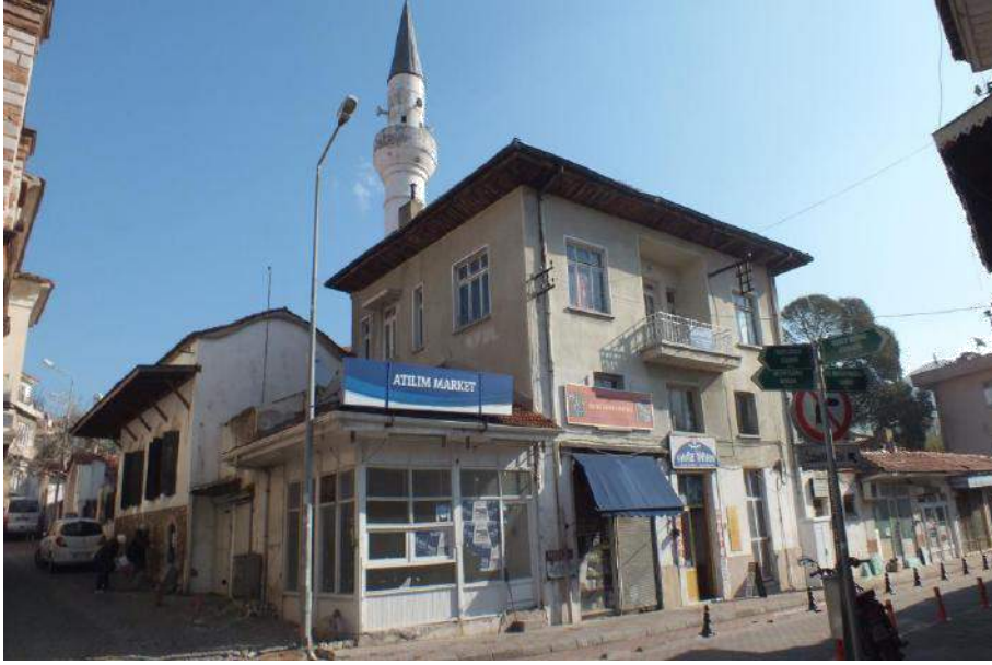
Fotoğraf 1- Muğla Şeyh Külliyesi, güneybatıdan genel görünümü.
